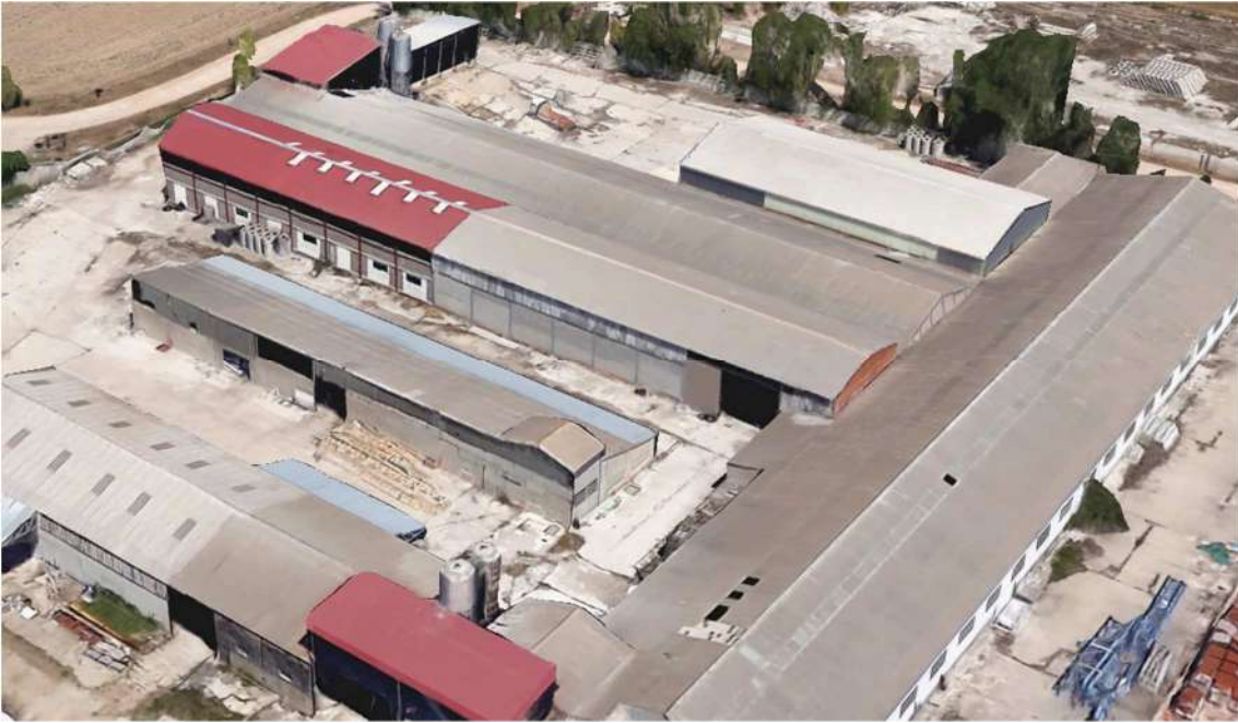
VISTA DE LAS NAVES EXISTENTES
