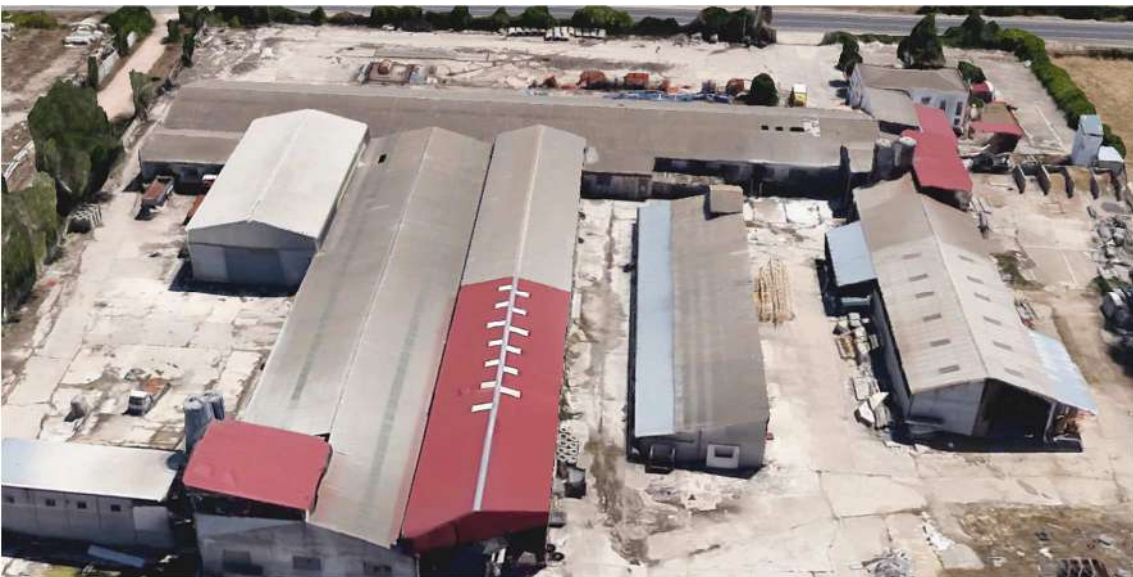
VISTA DE LAS NAVES EXISTENTES
