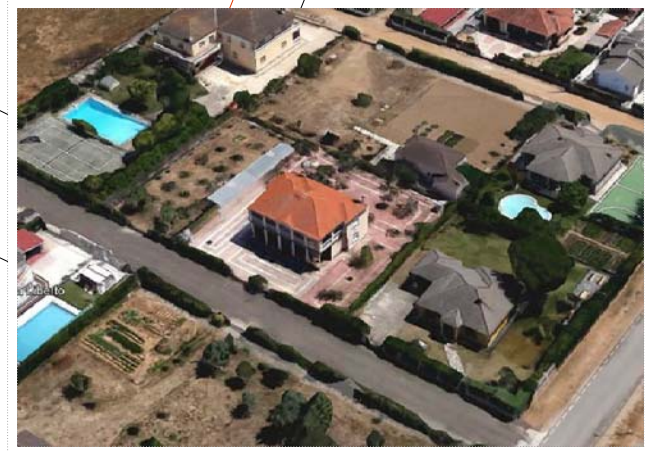
VISTA AÉREA DE LA VIVIENDA EXISTENTE
